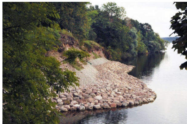
4.Attēls. Dievkalns pēc krasta stiprināšanas 2014.g.
