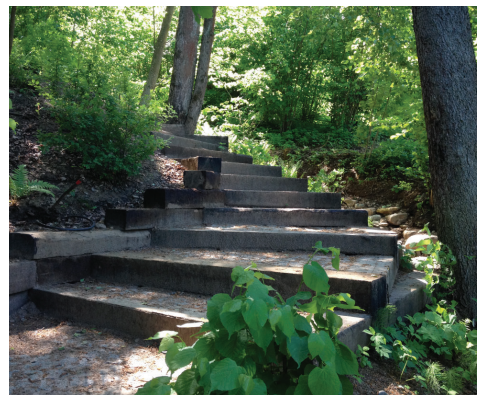
Pakāpieniem izmantoti dzelzceļa gulšņi ar granīta bruģakmeni
