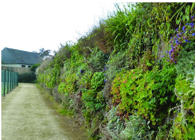
Attēls. Dzelzceļa līnijas skaņu aizsargvalņa veidošanas piemērs
