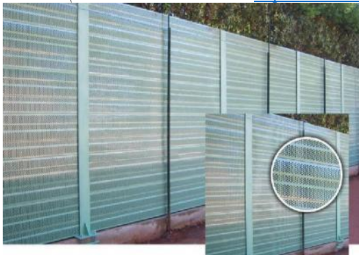
Attēls. Skaņu absorbējošo materiālu pielietojums akustikajās barjerās. Barjeras otra puse izmantojamā vītenaugu audzēšanai
