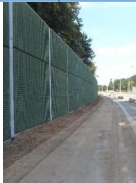
Attēls. Skaņu absorbējošo materiālu pielietojums akustikajās barjerās. Barjeras otra puse izmantojamā vītenaugu audzēšanai
