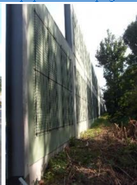
Attēls. Skaņu absorbējošo materiālu pielietojums akustikajās barjerās. Barjeras otra puse izmantojamā vītenaugu audzēšanai
