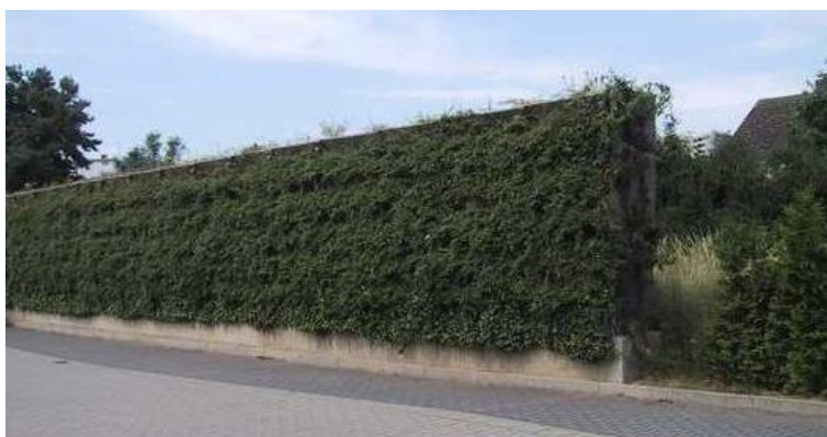
Attēls. Dzelzceļa līnijas skaņu barjeras veidošanas piemērs
