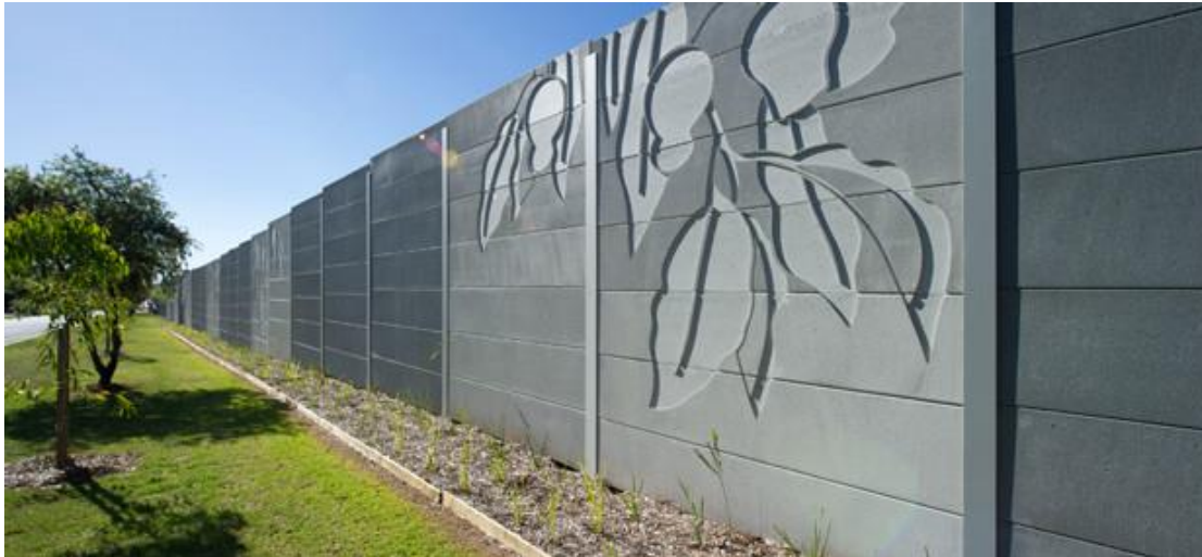
Attēls. Akustikās barjeras piemērs ar iestrādātu rakstu. Sidneja. Austrālija.
