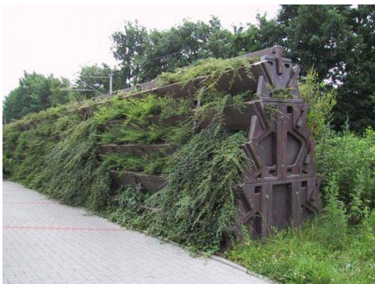
Attēls. Dzelzceļa līnijas skaņu barjeras veidošanas piemērs
