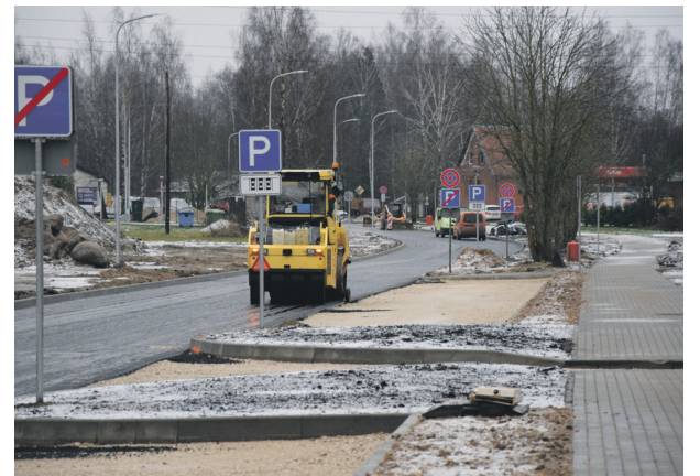
Ķeguma pilsētas Ogres ielā veikti rekonstrukcijas darbi.
