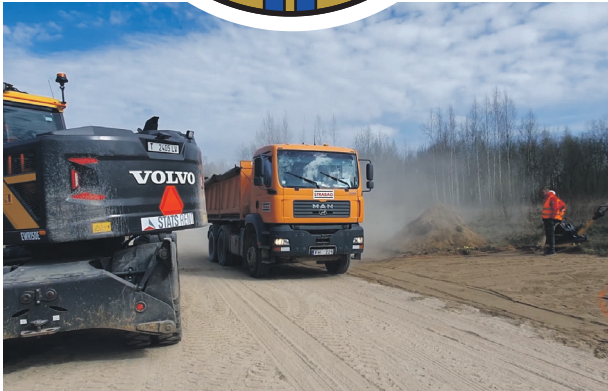
Projekta ietvaros veikta lauku grants ceļu pārbūve uzņēmējdarbības attīstībai Ķeguma novadā.
