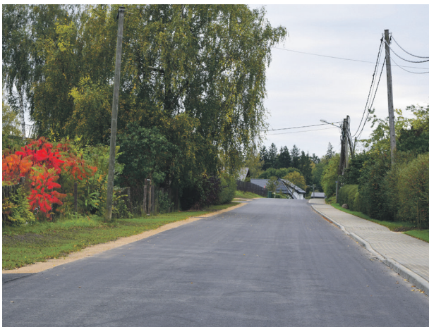
Ķegumā veikti Uzvaras – Priežu ielas asfalta seguma atjaunošanas darbi.
