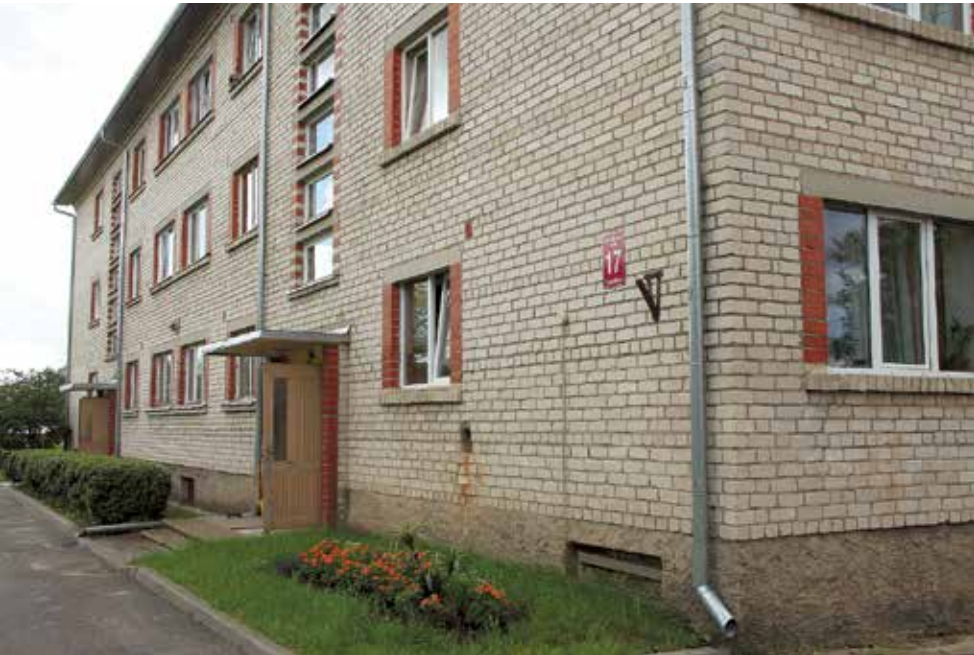
Dzīvokļu īpašniekiem sadarbojoties ar ēkas apsaimniekotāju SIA „Lielvārdes Remte”, daudzdzīvokļu ēkai Spīdolas ielā 17, Lielvārdē šovasar nomainīts savu laiku nokalpojušais jumts, uzlabota ventilācijas sistēma un nosiltināti bēniņi.
