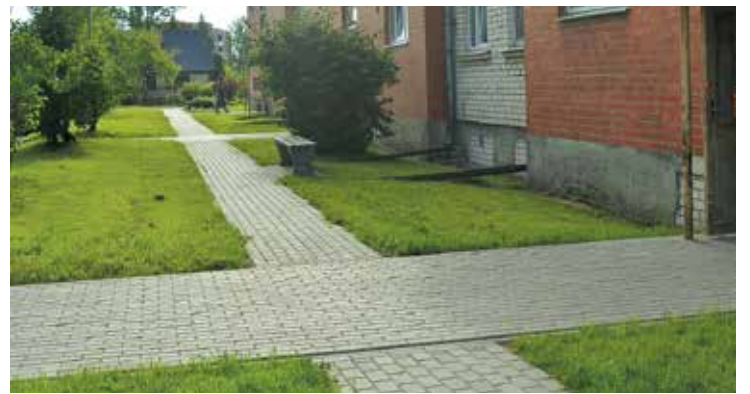
Pie nama Raiņa ielā 9A ir uzlikts bruģis un sakārtoti apstādījumi.
