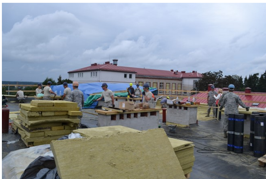
Ogres 1.vidusskolas jumta remontadarbus process 2014.gada vasarā
