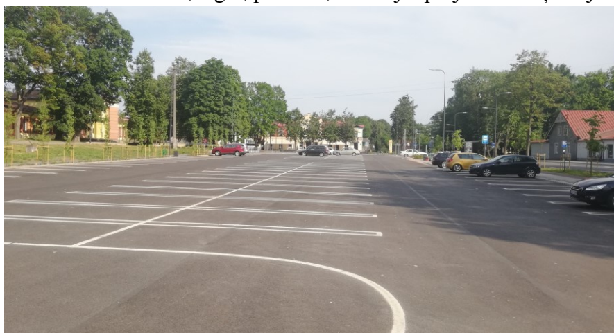
Skolas ielas pārbūves projekta ietvaros izbūvēts plašs laukums auto novietošanai
